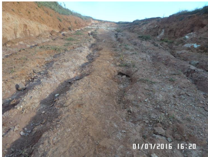
Figura 6.27 – Estrada interna – implantação de barragens galgáveis
