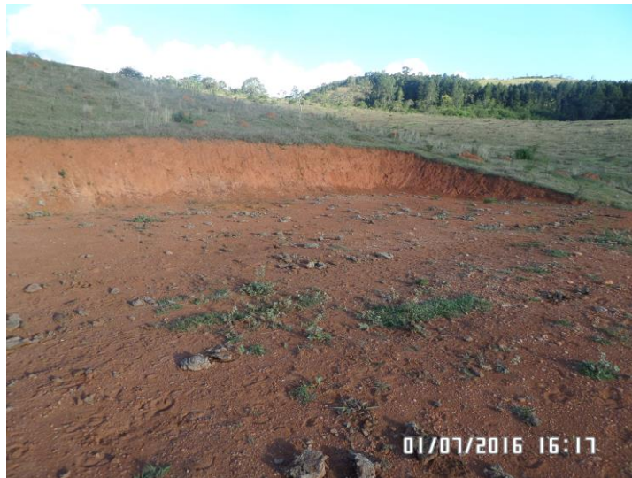
Figura 6.35 – Área de plantio – terraplanagem
